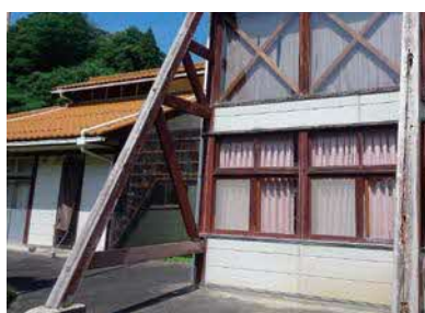
修繕する建物斜材
