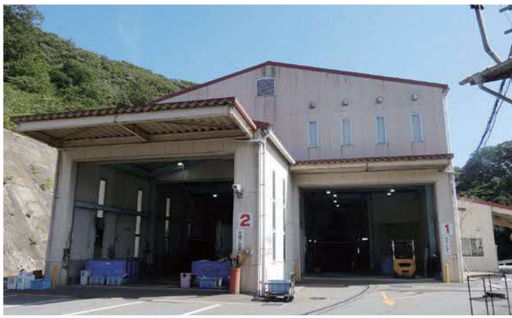
リサイクルプラザ（不燃物処理施設）
