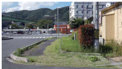
除草が必要な歩道
