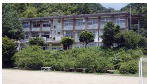
築55年が経過した海潮小学校
