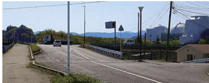
消えかかった横断歩道（加茂町柳橋付近）
