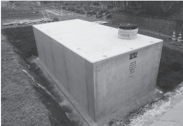
工事中の地下埋設型防火水槽
