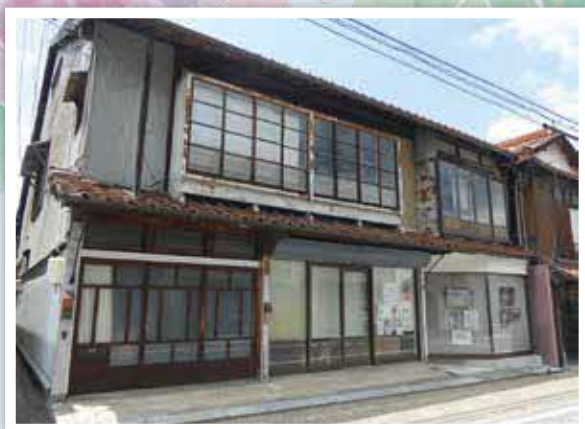
改修工事を予定する古民家（旧和田邸）
