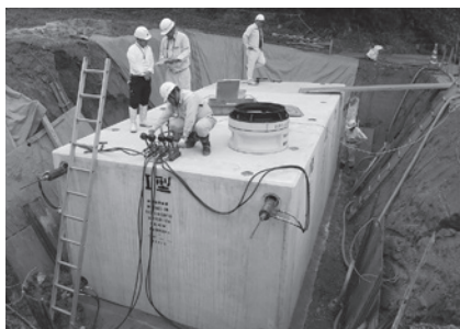
防火水槽設置工事
