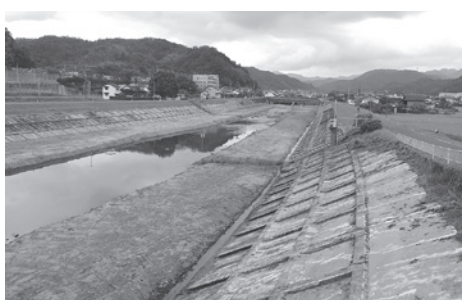
しゅんせつ 浚渫工事が進む赤川
