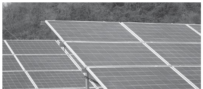
太陽光発電システム
