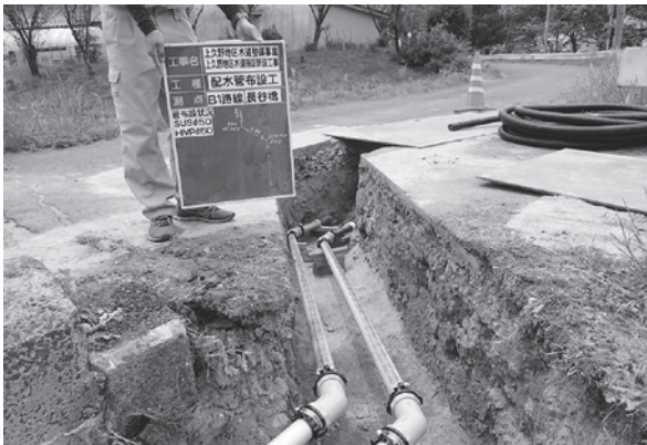
水道配水管布設工事の状況
