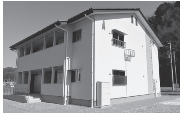
公営住宅三刀屋第2団地
