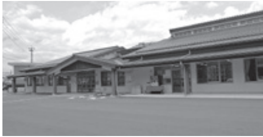
掛合町の地域づくり拠点 掛合総合センター・交流センター
