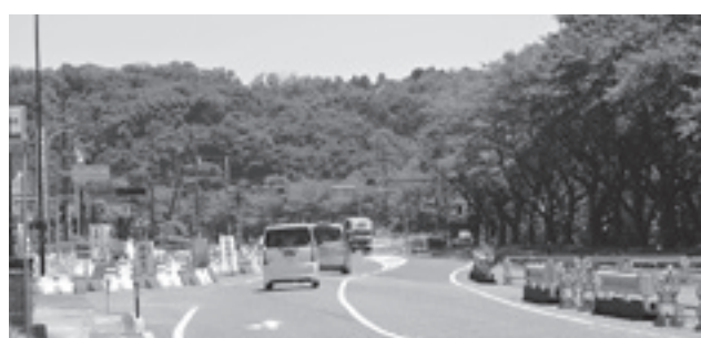
工事がはかどらない国道54号（尺の内）
