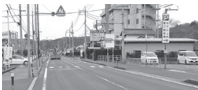
第4期工事が始まる国道54号4車線拡張工事
