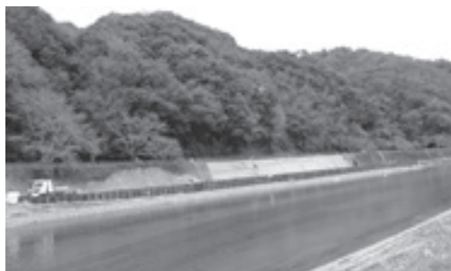
市道元神大別成木線災害復旧工事
