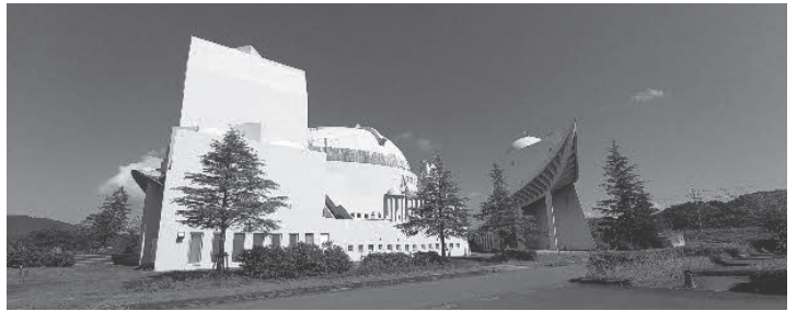
大規模修繕が必要な加茂文化ホール ラメール
