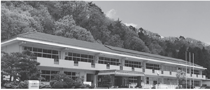
市内全小中学校に設置されている太陽光パネル
