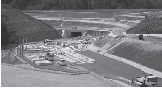
工事が進む雲南加茂スマートインターチェンジ
