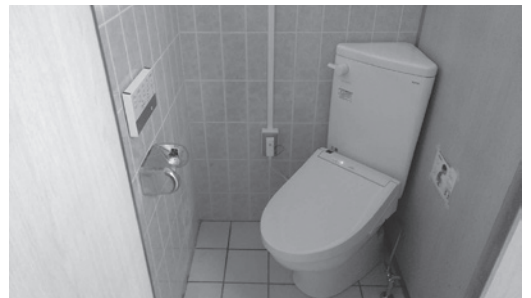
改修された学校のトイレ
