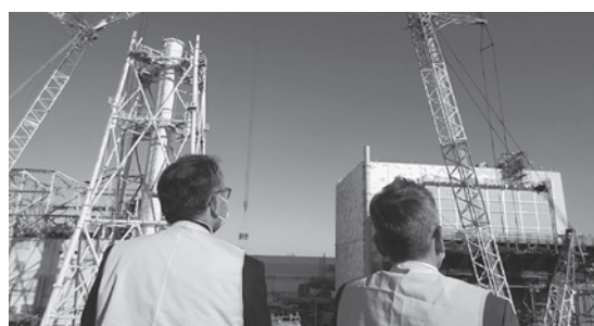
福島第1原発廃炉作業（東京電力提供）
