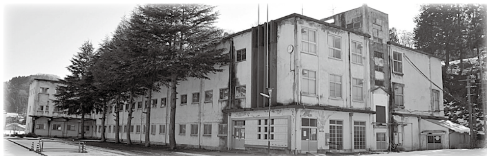
解体される大東分庁舎（旧大東中学校）
