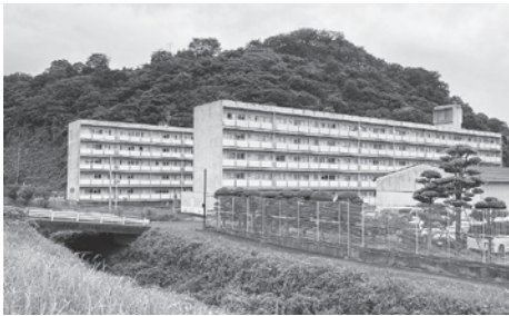
解体予定の木次団地
