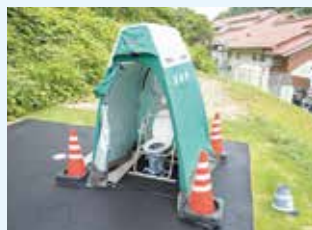
①マンホールトイレ ※トイレを設置した状態
