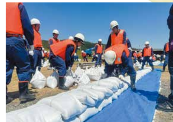
▲「改良積み土のう工」訓練の様子
