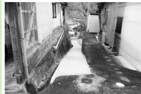
(引野自治会 自治会内通路コンクリート舗装) 事業
