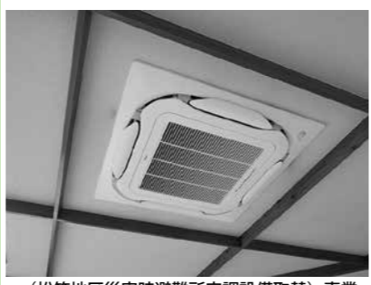
(松笠地区災害時避難所空調設備取替) 事業
