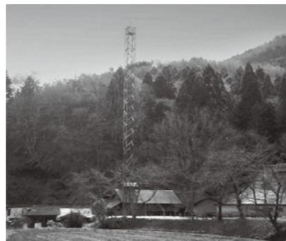
新設した避雷針鉄塔
