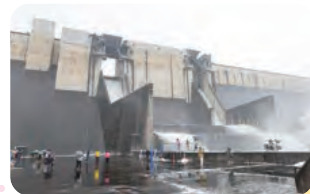
▲クレストゲート点検放流の様子
