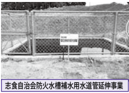
志食自治会防火水槽補水用水道管延伸事業
