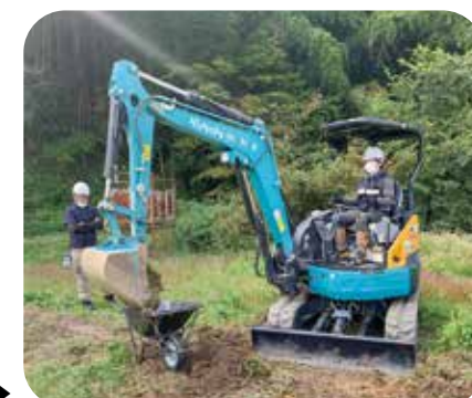
一輪車への土砂入れ練習▶
