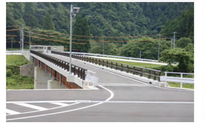
▲供用開始した小原橋
