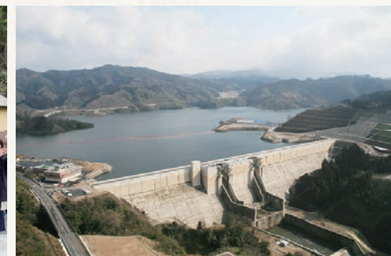
尾原ダム竣工（平成24年6月）
