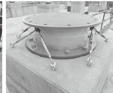
▲土台へ設置した免震装置
