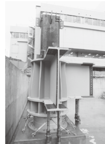
▲免震装置の上へ支柱を設置
