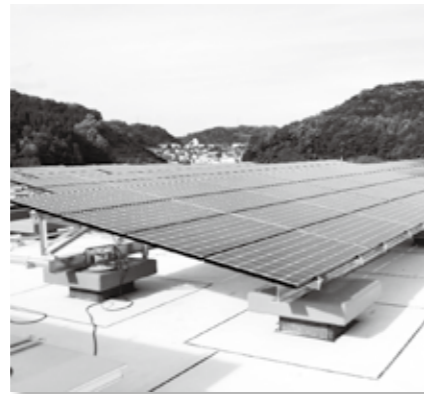
太陽光発電設備
