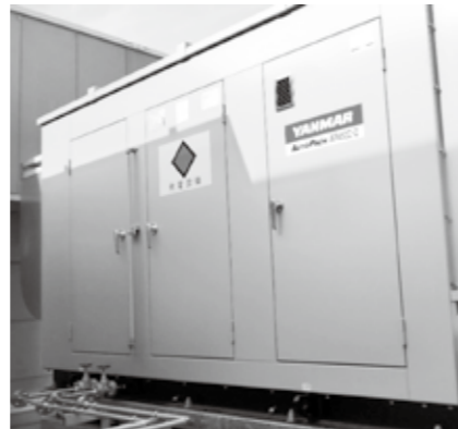
非常用発電機
