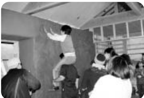
参加者は、肩車をして素手で泥を壁に塗り込んでいました
