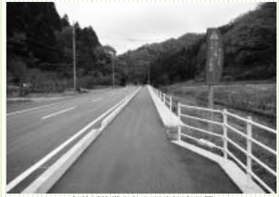
歩道が整備された下小河内工区
