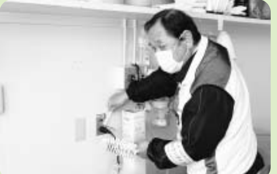
ボランティアさんによるコンセント点検・清掃
