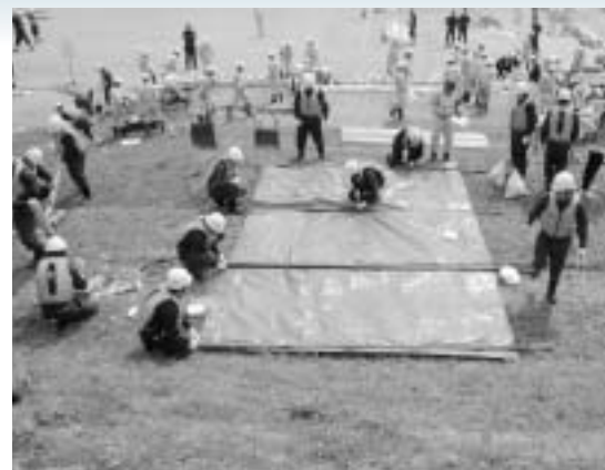
雲南市水防団三刀屋方面隊水防班によるシート張り工
