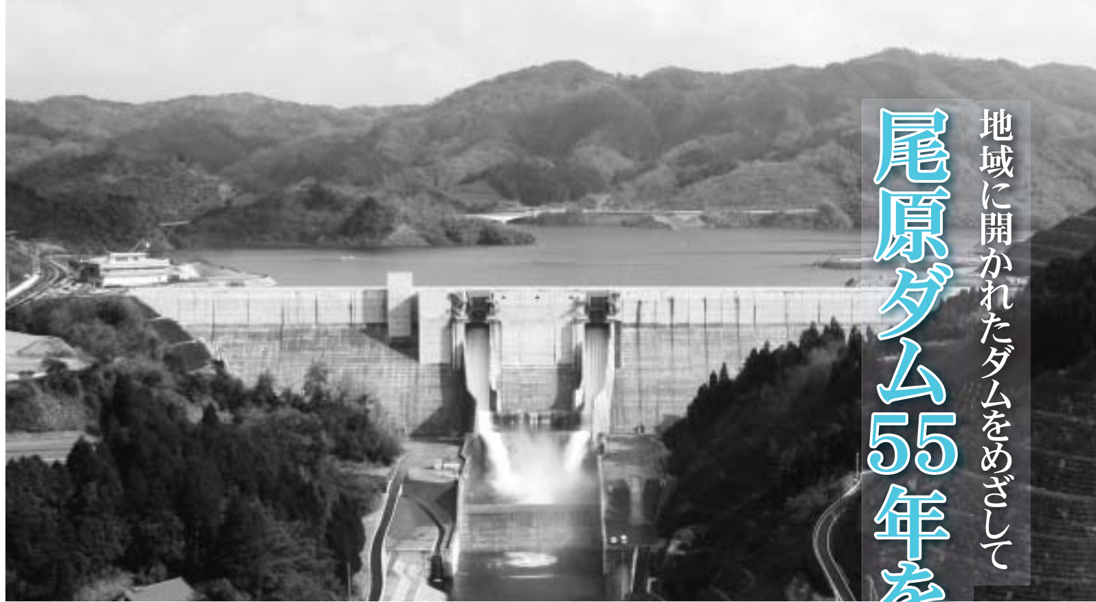
尾原ダム非常用放流設備試験放流（平成24年3月4日）
