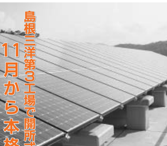
新工場の屋上に設置された太陽発電モジュール群
