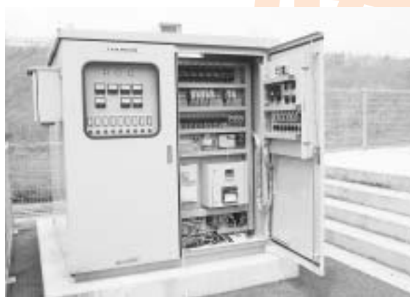
汚水処理制御盤
