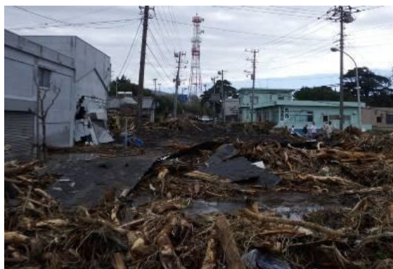
市街地の土砂等の流入状況
