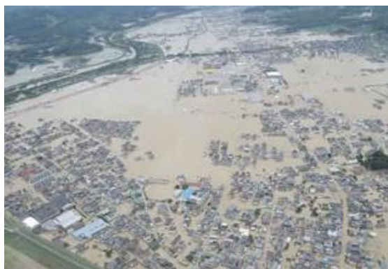
豪雨直後（岡山県倉敷市真備町）
