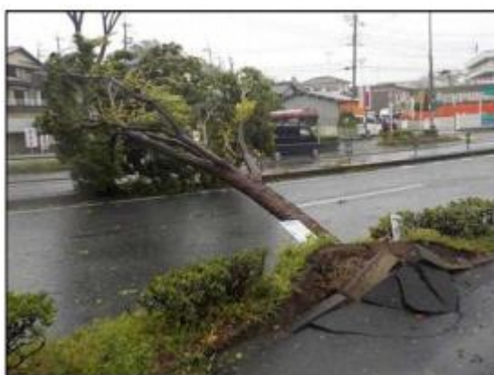
市街地における被災状況
