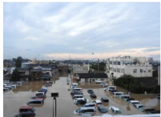
市役所本庁舎前の冠水
