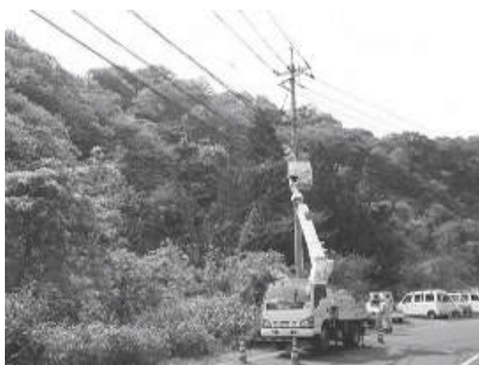
ケーブルテレビ伝送路設備の修繕作業
