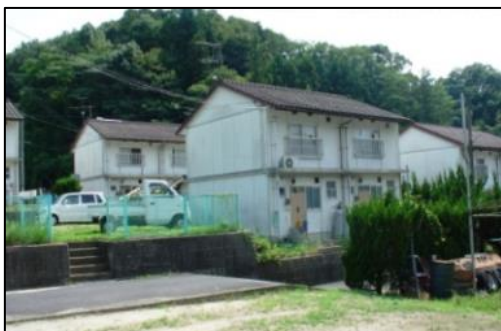
市営住宅 三峠団地
