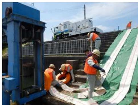
内容: 本訓練では、前日夜間に三谷川樋門を閉め2.0m程度の水を溜め豪雨災害の状況を再現し、当日は雲南市が所有する排水ポンプ車1台(水中ポンプ4台搭載)及び島根県が常設している固定ポンプ6台を使用して三刀屋川への排水作業を行います。
