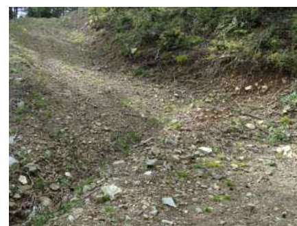
素掘りによる横断溝
