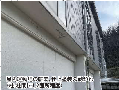
⑩ 屋内運動場 外壁
