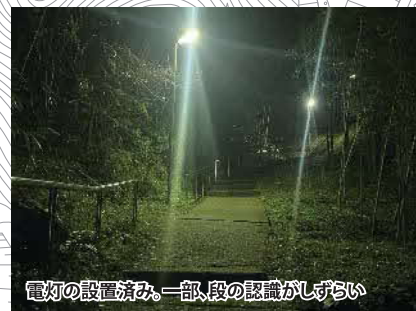
手摺設置済み。階段中腹部で、階段踏面に勾配があり危険
