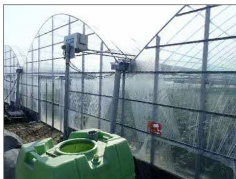
防犯カメラの設置
