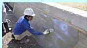
老朽化した水路壁のコーティング
