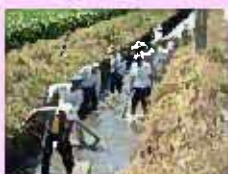
水路の泥上げ
