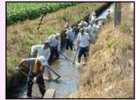
水路の泥上げ
