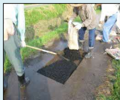
農道の部分補修
