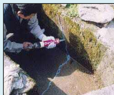
ひび割れの補修
