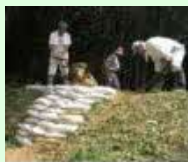
漏水箇所の補修
