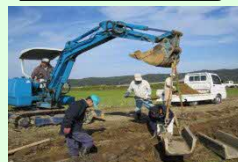
コンクリート水路の更新
