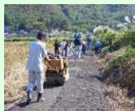
未舗装農道の舗装
