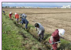
水路の泥上げ
