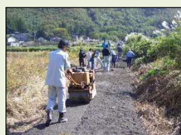
未舗装農道の舗装
