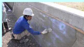
老朽化した水路壁のコーティング
