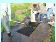
農道の部分補修
