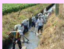
水路の泥上げ
