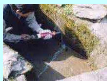
水路のひび割れ補修
