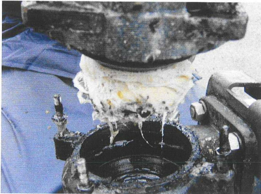
インペラーに噛み込んだ異物
