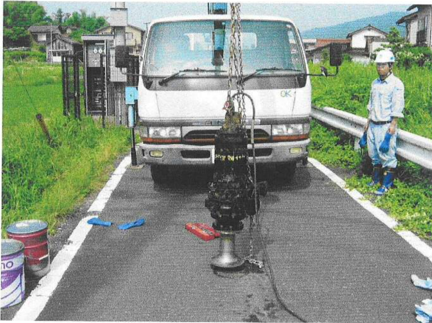
ポンプ引き上げ
