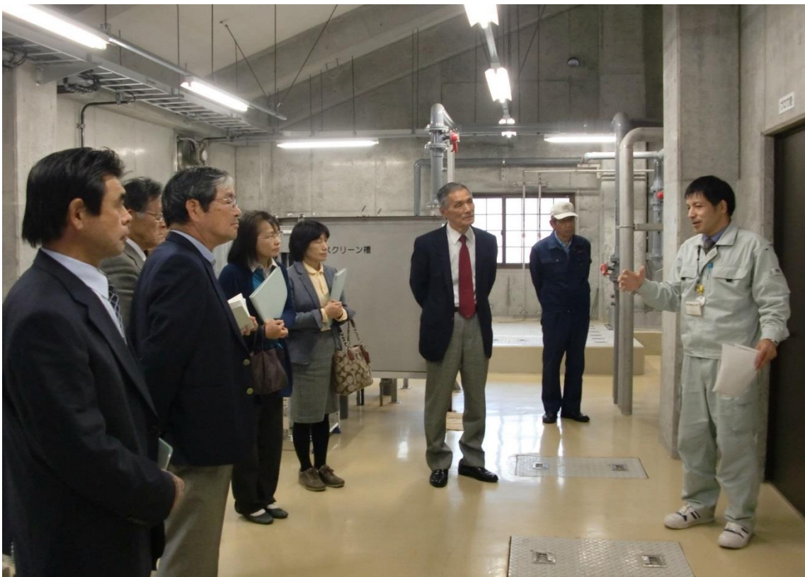
【視察 吉田町農業集落排水処理場】
