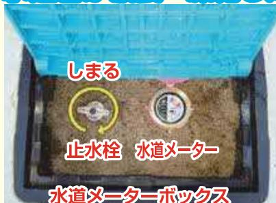
水道管が破裂したときは、応急措置として、まずメーターボックスの中にある止水栓（※）を閉めて、**指定給水装置工事事業者**に修理を依頼してください。
