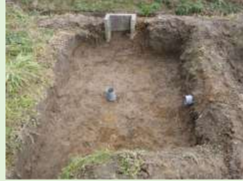
▲排水パイプと水田と連結する魚道パイプを整備
