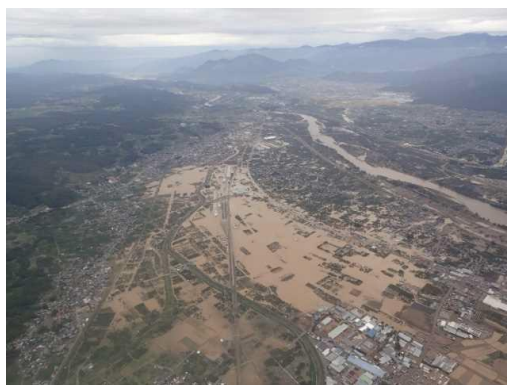
千曲川の破堤状況（長野市穂保地先）
