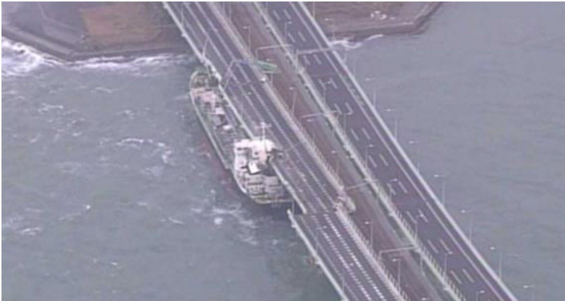
関空連絡橋へのタンカーの衝突
