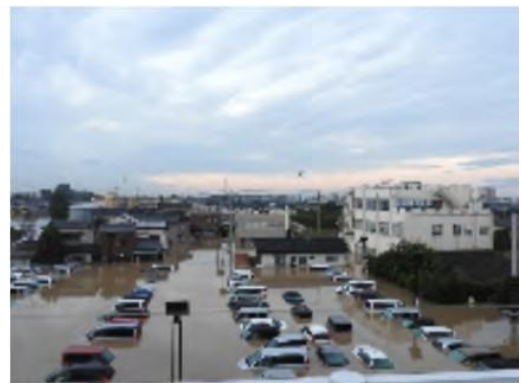
市役所本庁舎前の冠水
