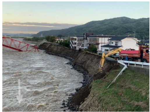
千曲川堤防欠損箇所（上田市諏訪形地区）
