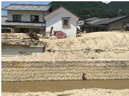
河川周囲の土砂堆積状況（広島県呉市天応地区）
