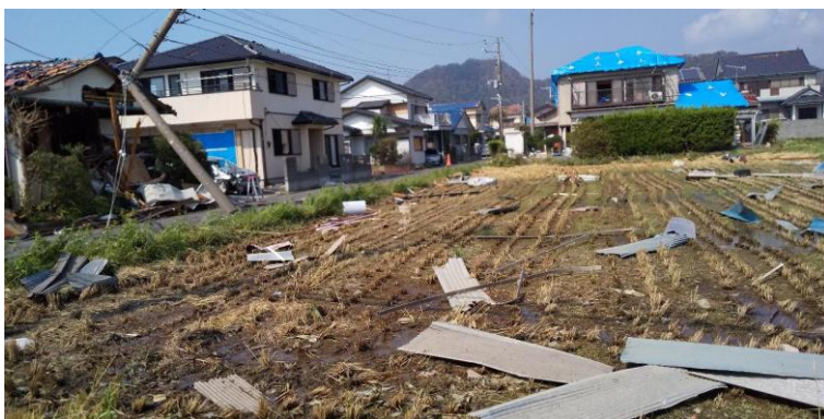
神奈川県三浦市被害状況
