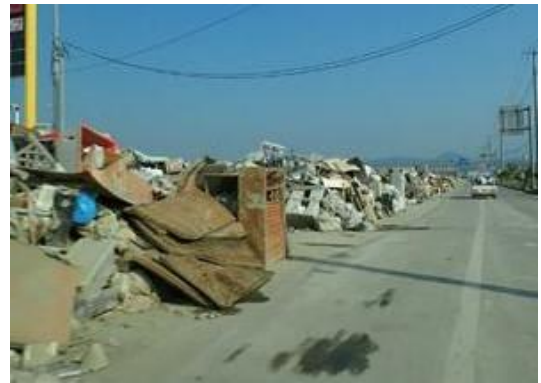
豪雨直後（岡山県倉敷市真備町）
