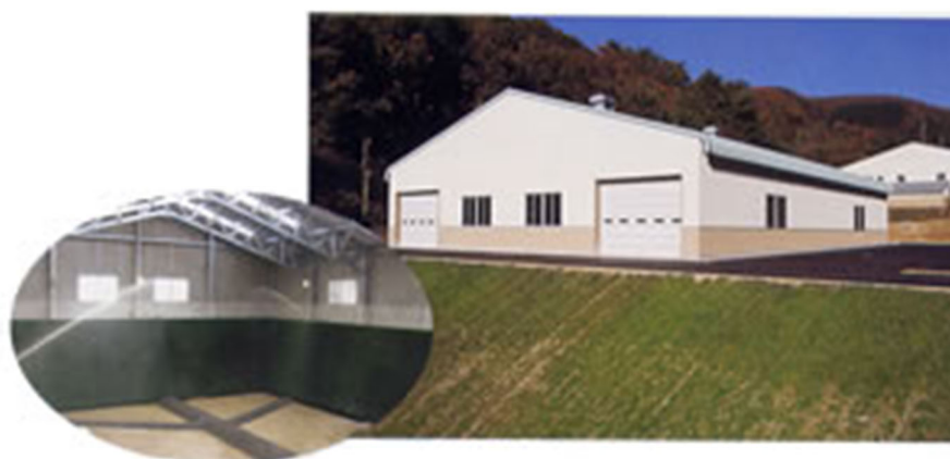
写真：いいしクリーンセンター（クローズド型処分場）
