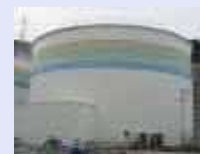
復水貯蔵 タンク
