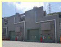
ガスタービン 発電機
