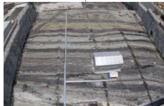
(写真は3号機原子炉建物エリアの岩盤)
