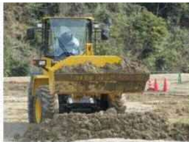
▲がれき撤去訓練
