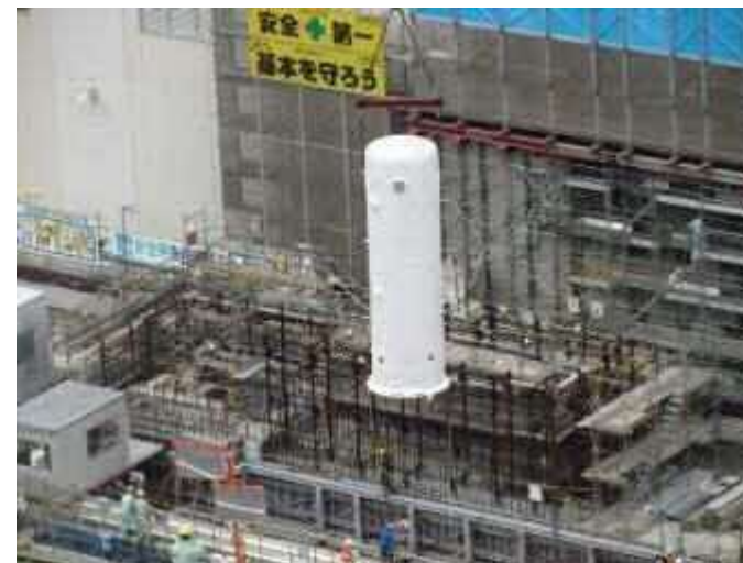
▲フィルタ吊りこみ作業(2014年8月)
