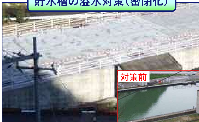
貯水槽の溢水対策(密閉化)
