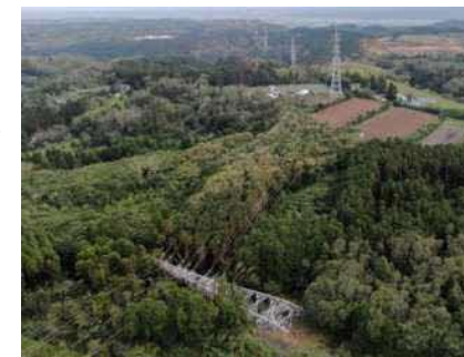
鉄塔設備の倒壊（君津市）
